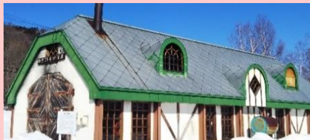
雨宮21号機関庫の改修
