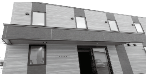
町で整備した遠軽高校の学生寮
