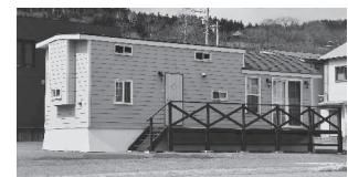
▲トレーラーハウス
