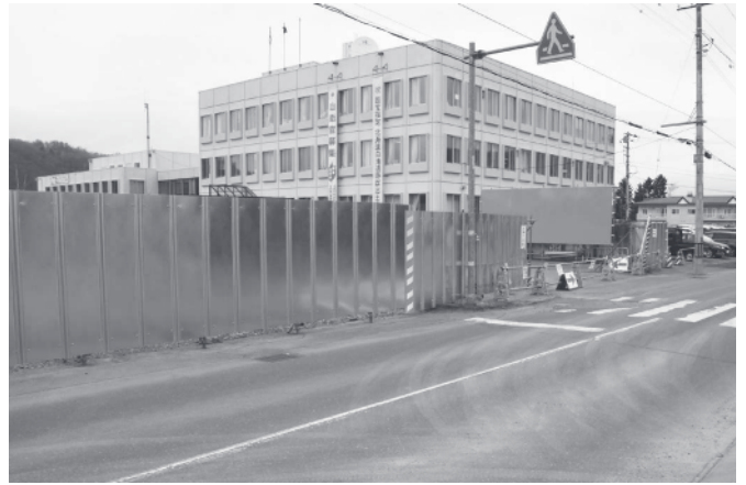
(建設現場写真：仮囲い)
