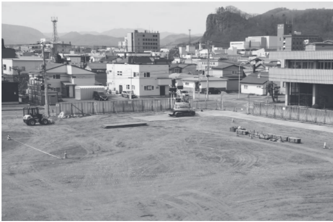
(建設現場写真：車両など)
