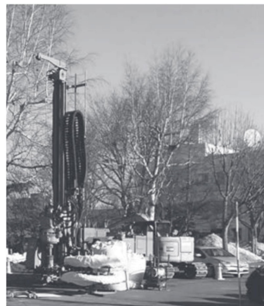
庁舎前庭での採熱性能調査
