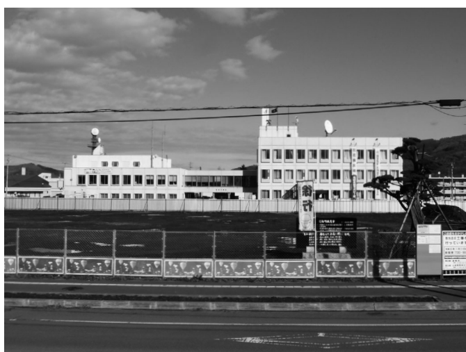
(現庁舎前庭の整地状況)
