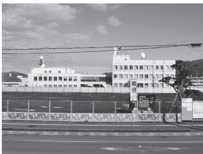
(現庁舎前庭の整地状況)
