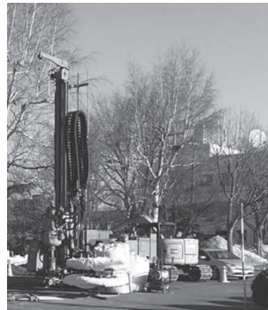
庁舎前庭での採熱性能調査
