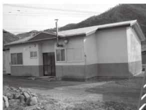
老朽化も進んでいる職員住宅
