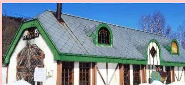
雨宮21号機関庫の改修
