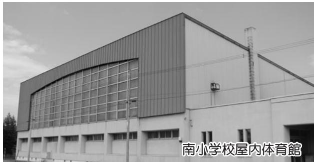
**問** 教育長 南小学校の新耐震化診断の結果、大規模地震時において体育館屋根及び壁の耐力不足があり、新年度より3か年計画で、この不足する部分の補強を大規模改修工事をと併せて行うものです。地震時の児童の安全性を確保するとともに、避難場所として地震に対し倒壊、または崩壊する
