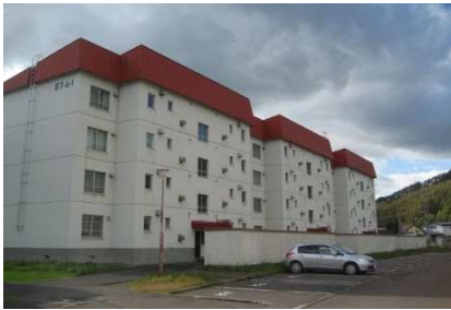
61-A-1棟（改修中）
