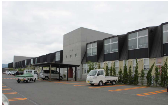
オガールプラザ外観一
