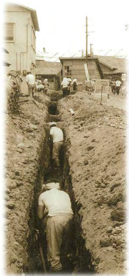
写真：創設期の水道管布設工事 (出典：遠軽の水道と下水道)
