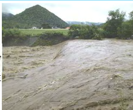
清川頭首工（濁水時）
