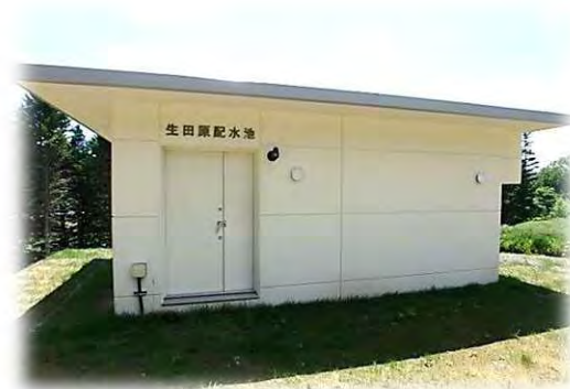
生田原配水池
