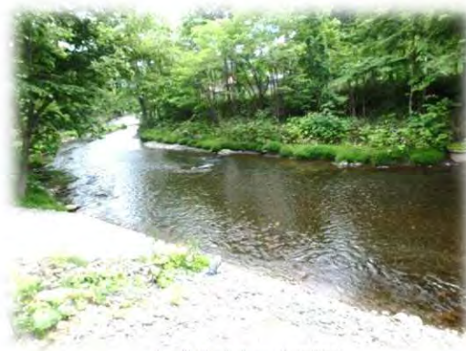
丸瀬布川取水施設
