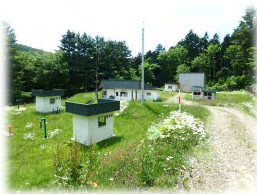
丸瀬布浄水場
