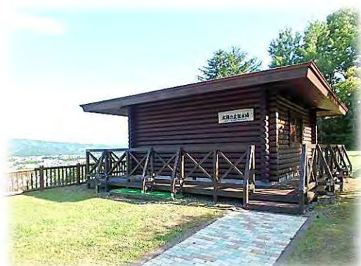
太陽の丘配水池
