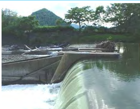
清川頭首工（平常時）
