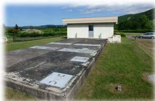
沈砂池・導水ポンプ井
